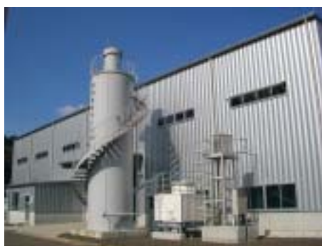
写真 4.3 プラント全景
