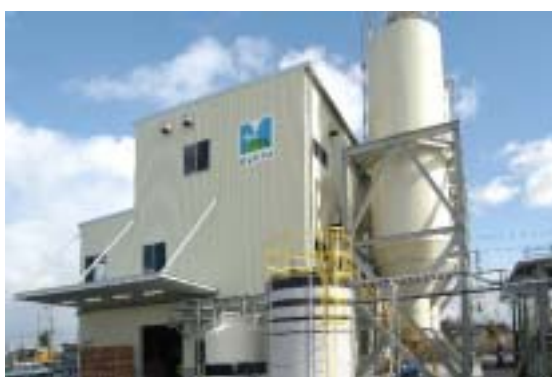
写真4.1 プラント全景
